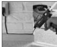
Poser des câbles téléphoniques.
