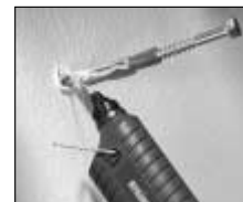
Lockere Dübel befestigen.
