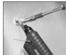
Fixer des chevilles desserrées.
