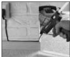
Trækning af tefonkabler.
