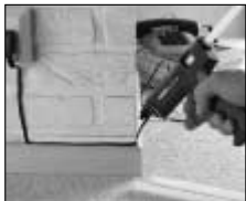
Colocar cables de teléfono.
