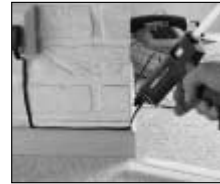
Förläggning av telefonkabel.
